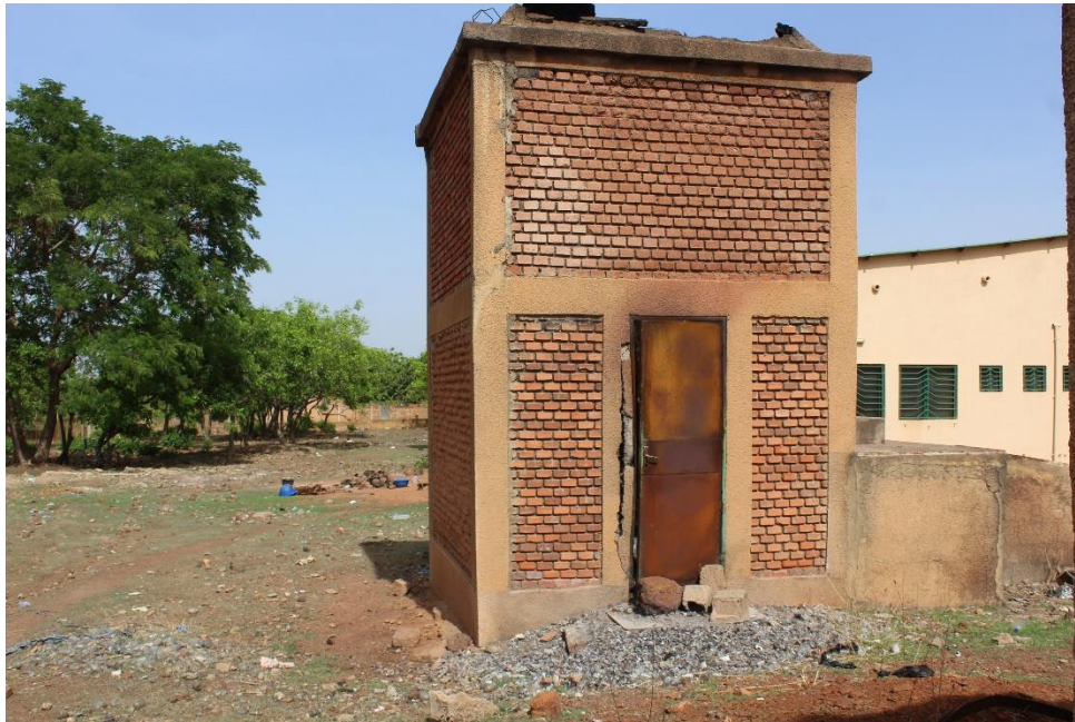
Photo 9 : Incinérateur du District sanitaire de Dano
